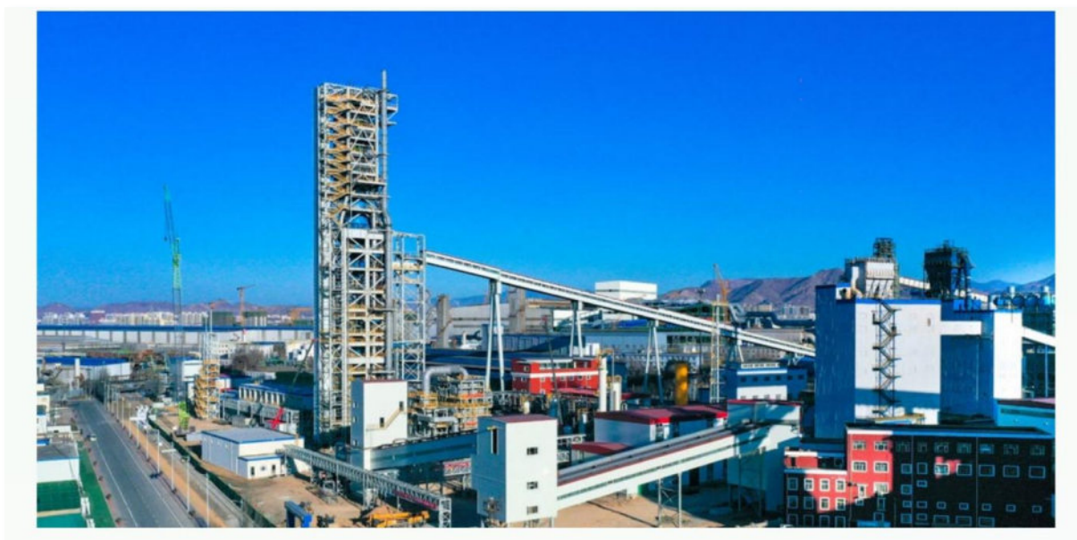
图 4-11 河钢集团氢冶金示范工程 31
