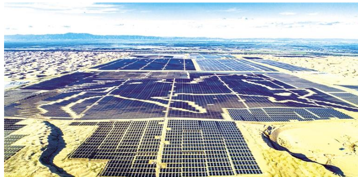
▲达拉特旗光伏发电应用领跑基地
