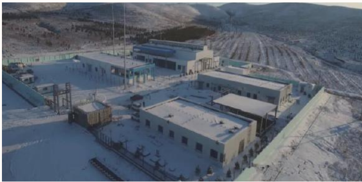
图 2.14 河北沽源风电制氢项目
