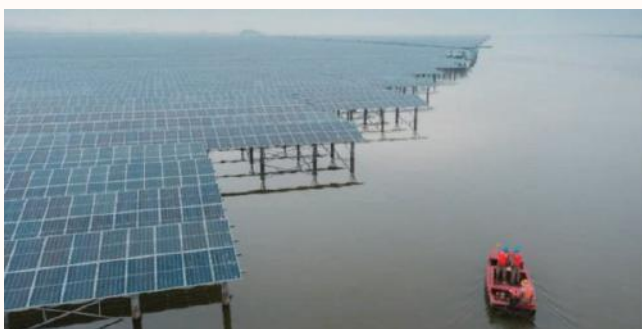
图 3.12 浙江温州泰瀚 550 兆瓦渔光互补项目
