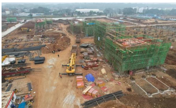
图 35 海南矿业氢氧化锂项目现场建设图
