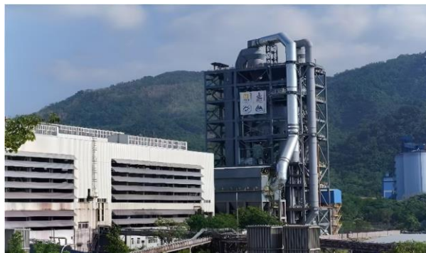
图 16 海南矿业悬浮磁化焙烧项目图
