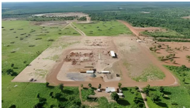
图 37 布谷尼锂矿采矿及选矿建设现场图
