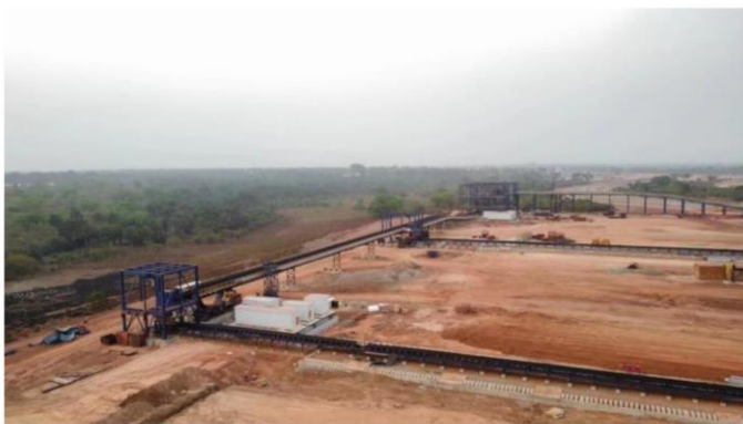
图87：西芒杜铁矿配套马瑞巴亚港通用带式输送机项目
