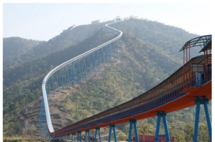
图90：缅甸达贡山镍矿石管状带式输送机项目
