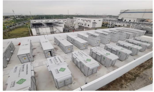
图23: 全球首例由电化学储能系统黑启动 9F 级重型燃机项目
