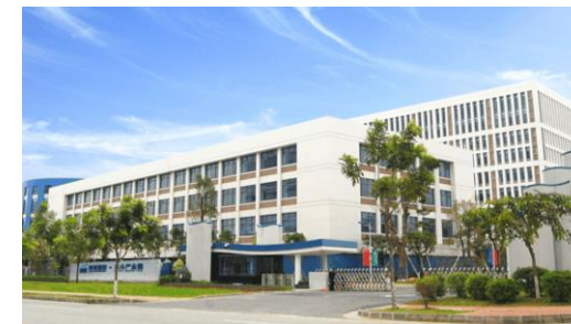
海格通信·北斗产业园
