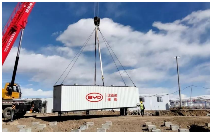
图31: 比亚迪储能液冷系统 CubeT 28 正在海拔 4500 米安装
