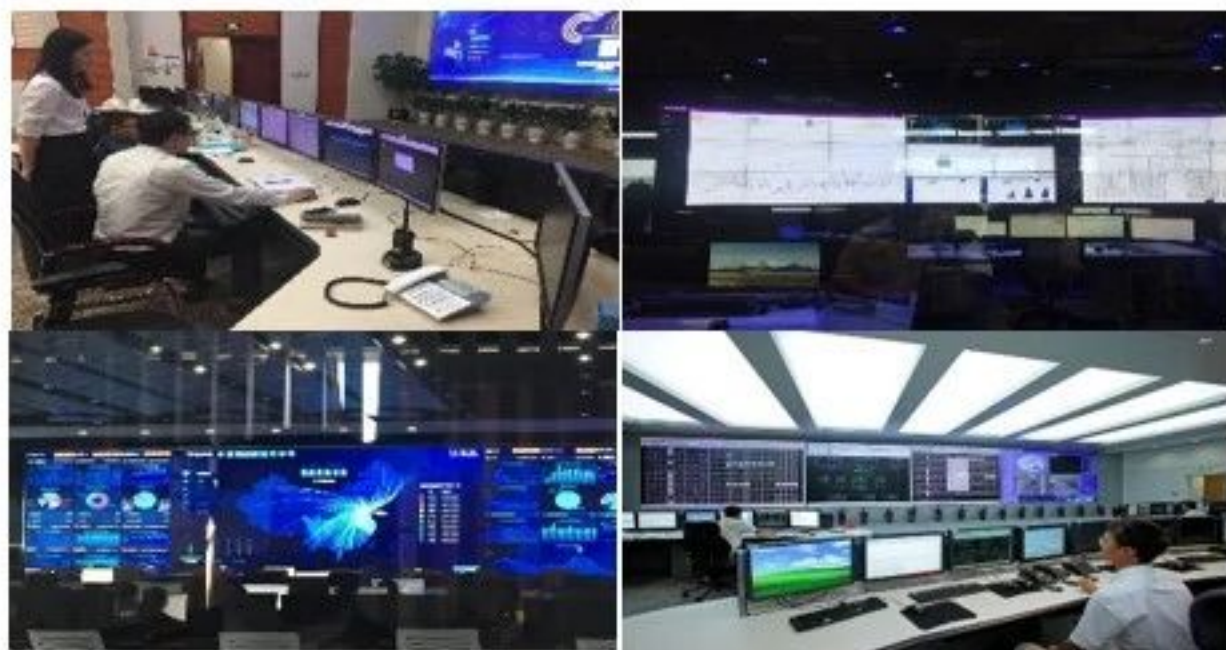
传统配电监控中心
