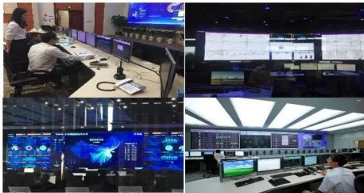
传统配电监控中心
