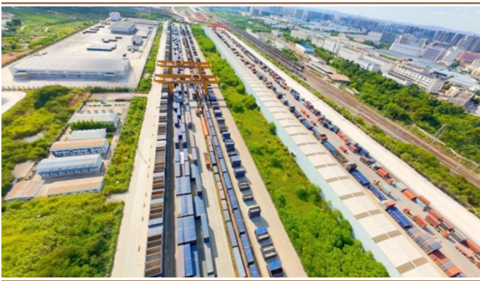
图 148：南宁铁路国际港集装箱作业区
