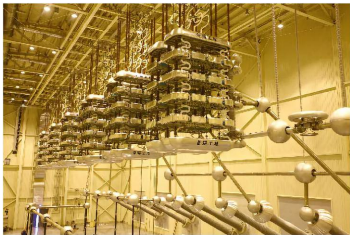
图22. ±800kV/5000A 特高压换流阀
