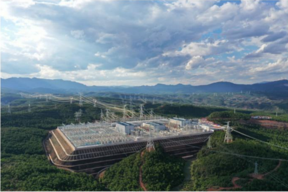
图27. 乌东德电站送电广东广西特高压多端柔性直流示范工程云南送端昆北换流站
