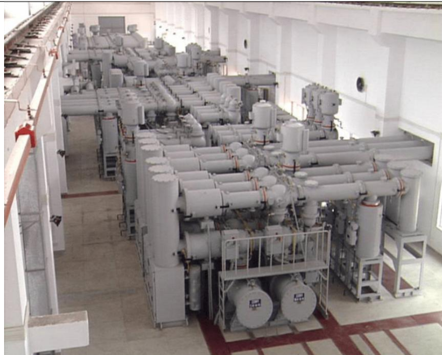
图11. 组合电器设备示意图
