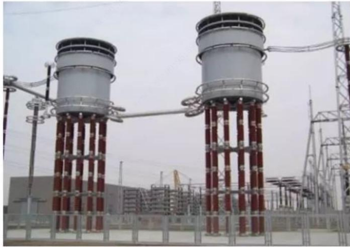
图24. 干式平波电抗器示意图
