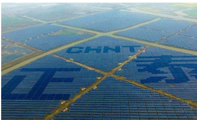
图10. 正泰新能源乐清 150MW 农光互补项目
