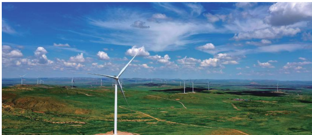
图 4-3 全国首个“风火储”沙戈荒新能源基地项目——位于内蒙古锡林郭勒盟的华能北方上都百万千瓦级风电基地
