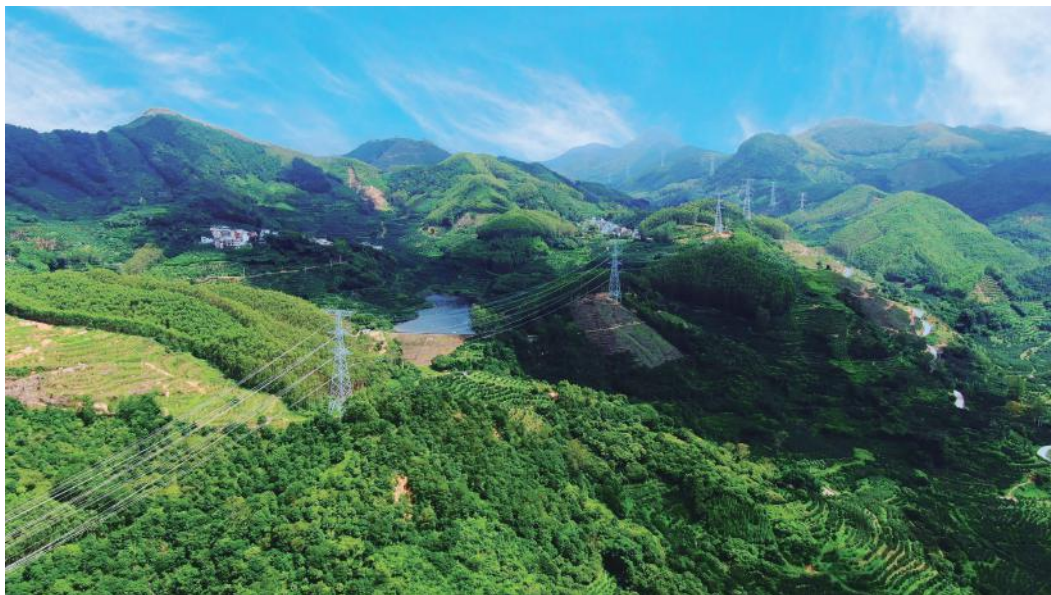
图 1-2 闽粤电力联网工程
