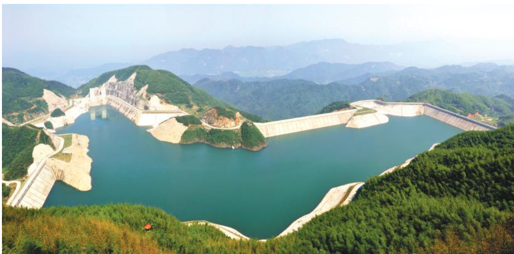
图 4-7 湖南黑麋峰抽水蓄能电站
