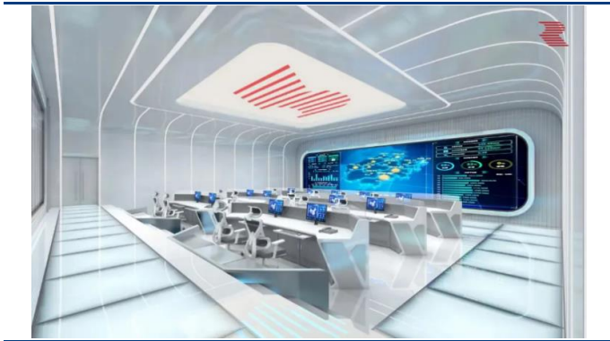
图表 48 润泽（廊坊）国际信息港智算中心算力调度大厅
