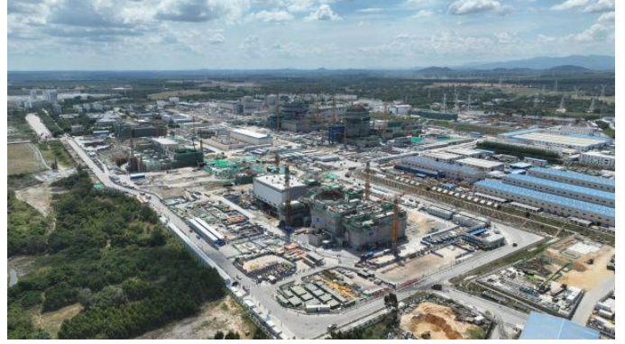
图 43：中国“玲龙一号”反应堆施工现场情况
