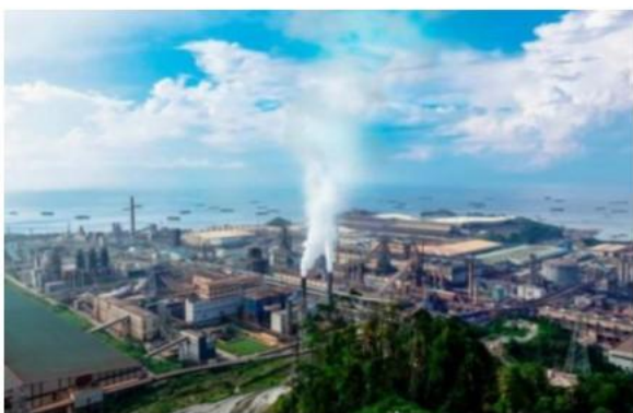
中国民生银行助力德龙集团落地东南亚最大钢铁项目
