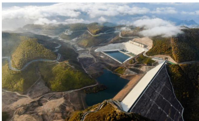
图 35：全国投运容量最大的丰宁抽水蓄能电站
