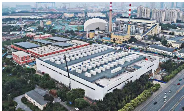
图 39：大连液流电池储能调峰电站全景
