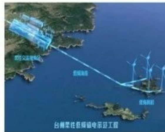
台州40.5千伏柔性低频输电工程
