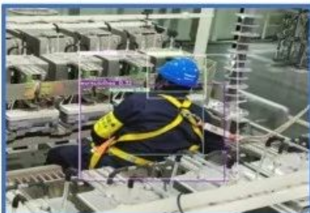
阀厅设备-人员-环境自动检测（安全帽+安全带+阀塔污秽+漏水...）
