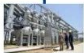
整站辅助监控
