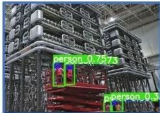
阀厅设备-人员-环境自动检测（安全帽+安全带+阀塔污秽+漏水...）
