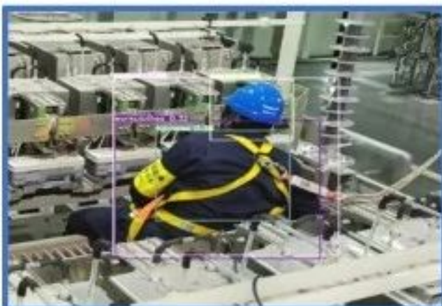
阀厅设备-人员-环境自动检测（安全帽+安全带+阀塔污秽+漏水...）
