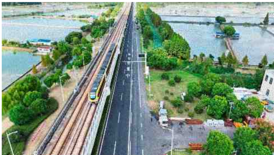
图3-8 无人机公路巡查工作场景
