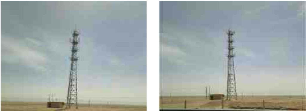
图 1-4 二号机场安装处
