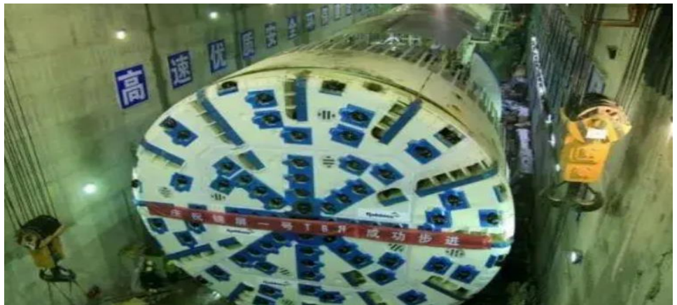
图表 31：案例：锦屏二级水电站施工中的 TBM 掘进机
