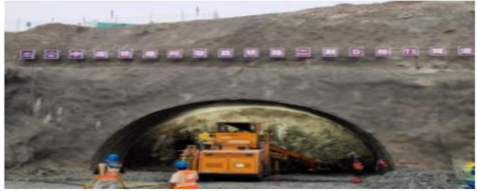
图表 48：阿联酋伊蒂哈德联邦铁路隧道施工现场
