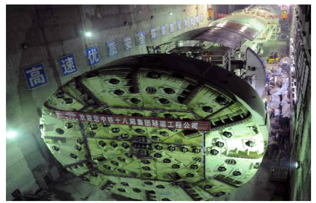
图表 28：锦屏引水隧洞施工现场
