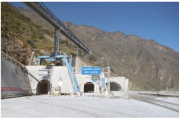
图表 27：锦屏引水隧洞外景
