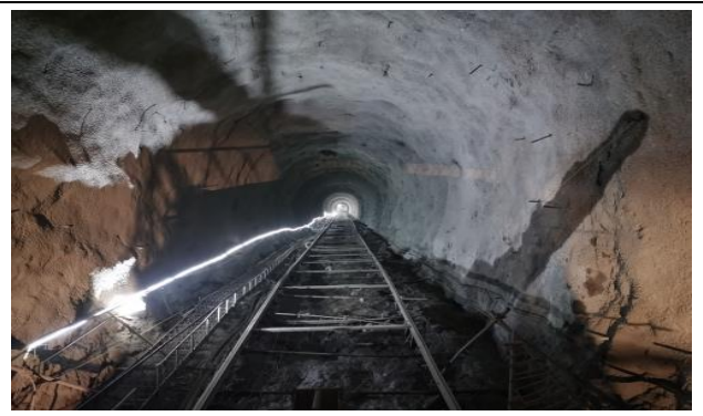
图表 30：案例：水电站斜井施工
