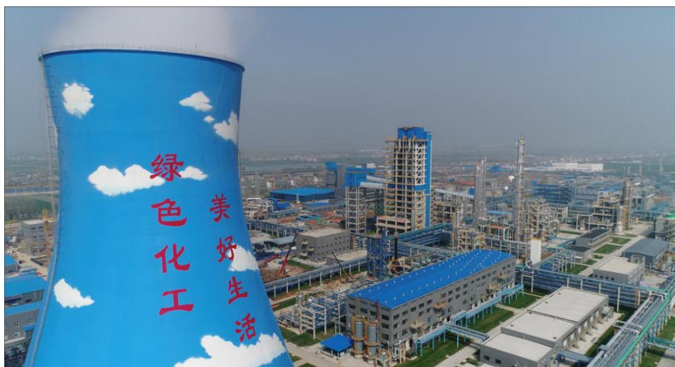
图表 54：安徽昊源化工集团半废锅航天炉
