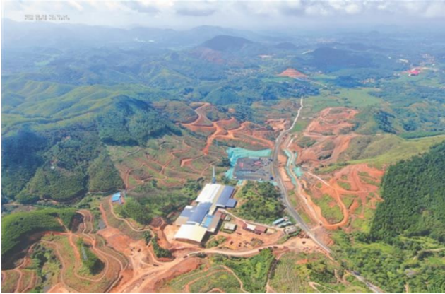
图表 41：马道枢纽现状
