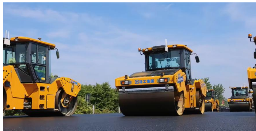
图：徐工无人施工集群助力沈海高速施工
