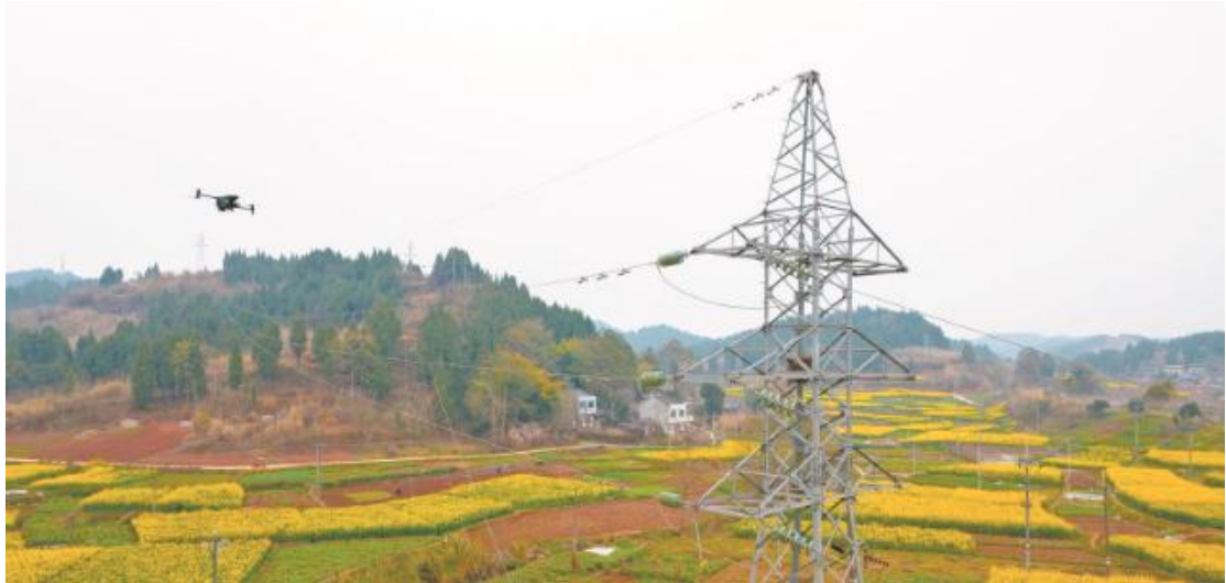
图 76 国网四川：无人机根据提前设定的飞行轨迹和拍照点位开展飞巡
